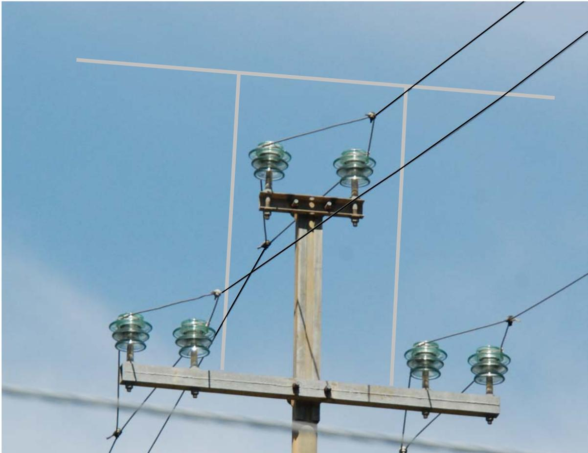
**Figura 11:** posatoio preferenziale su sostegno di media tensione con isolatori rigidi portanti
