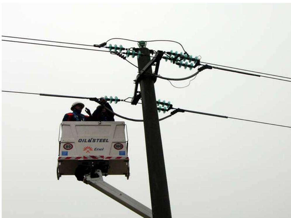
**Figura 5:** intervento di sistemazione dell'isolamento con cestello elevatore (Sondrio, 2011).
