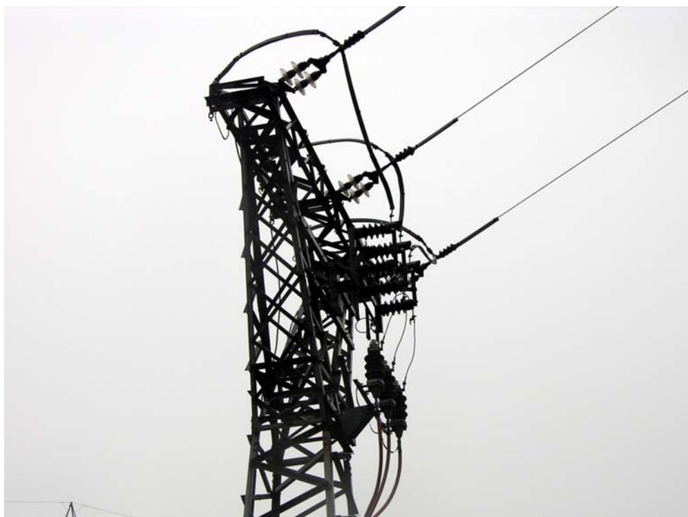
**Figura 6:** tralicci isolati con profilo in gomma e nastro autoagglomerante (Sondrio, 2011).
