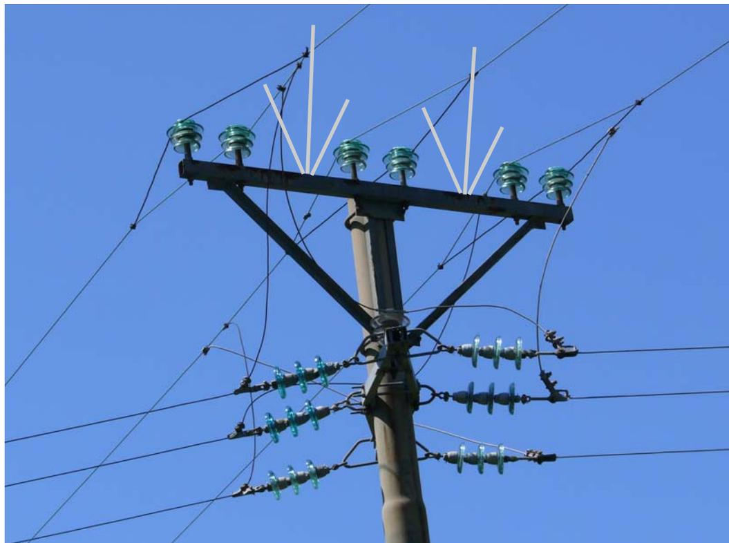
**Figura 9:** dissuasori su sostegno di media tensione
