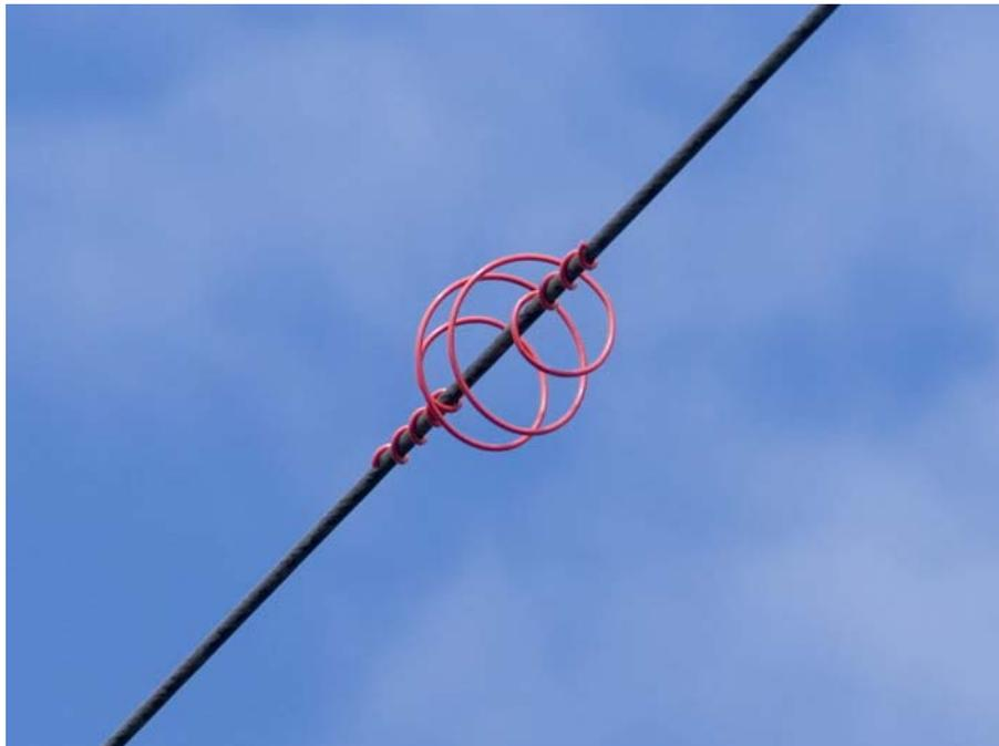
**Figura 12:** spirale colorata in plastica per la segnalazione dei cavi.
